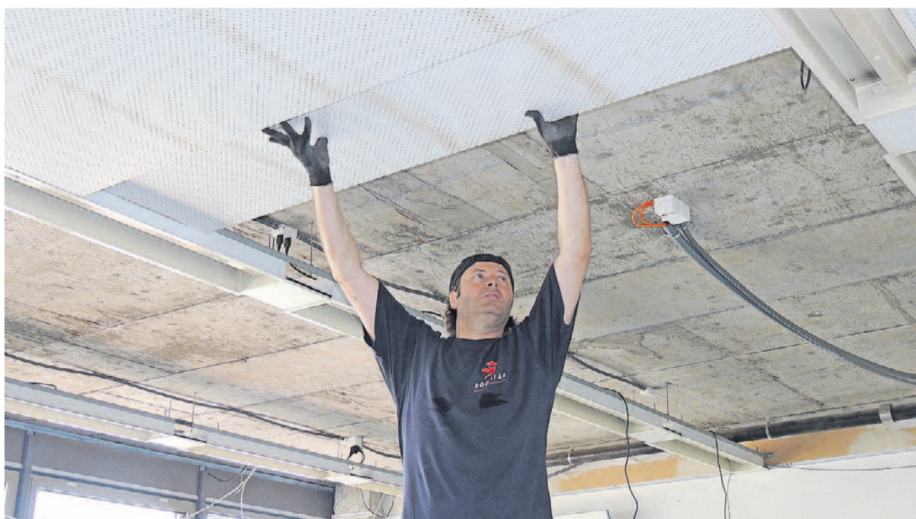
Auch die Decken hat man erneuert und damit für eine bessere Isolation gesorgt.
