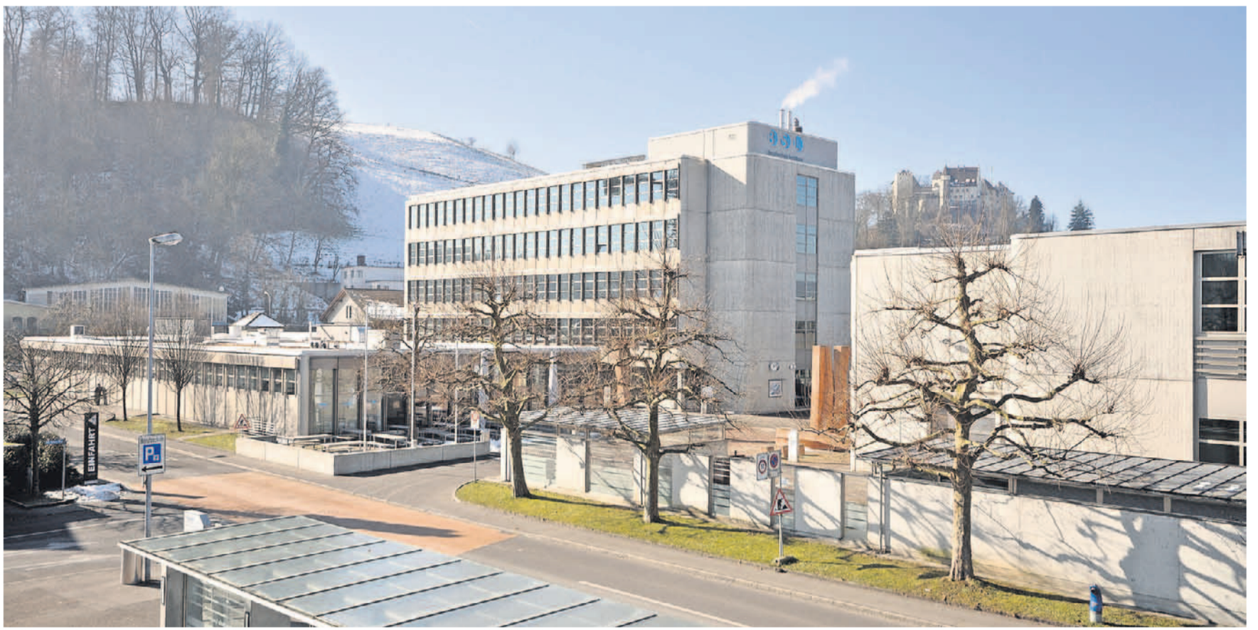
So sieht die Berufsschule Lenzburg nach der umfassenden Sanierung aus.
