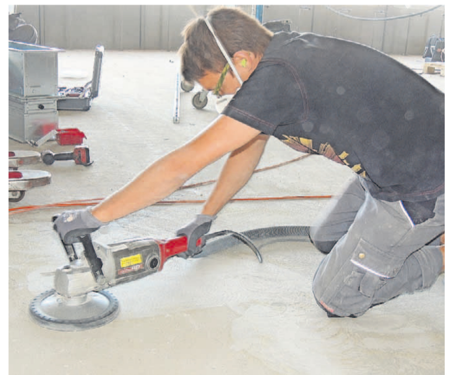
Es wurde hart gearbeitet, damit das Gebäude energietechnisch auf dem neuesten Stand ist.
