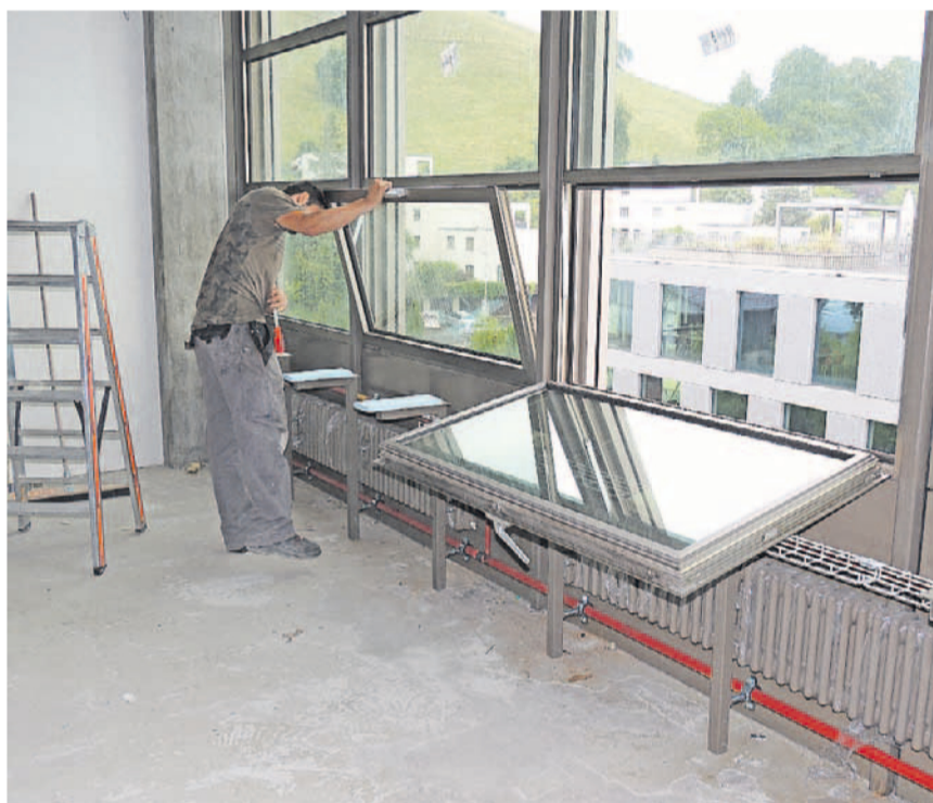
Die Fenster wurden ersetzt, um die Dichtigkeit sicherzustellen.
